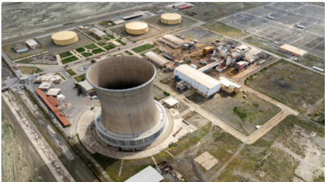
نیروگاه سیکل ترکیبی خوی
